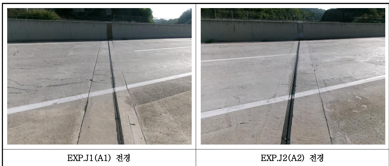
【사진 35.3.40】 신축이음장치 전경
