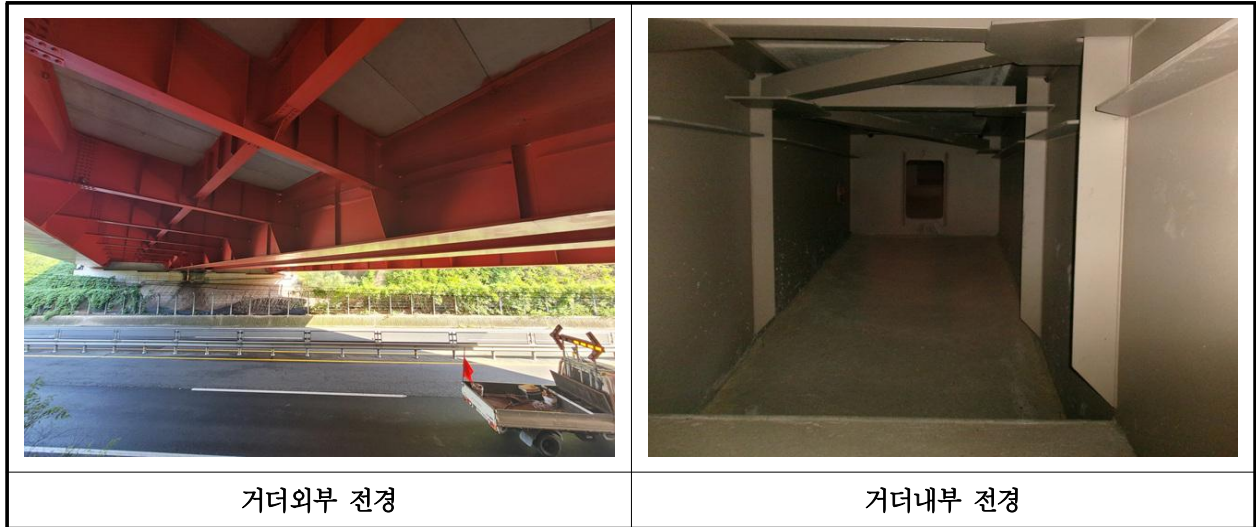
【사진 35.3.29】 거더 전경
