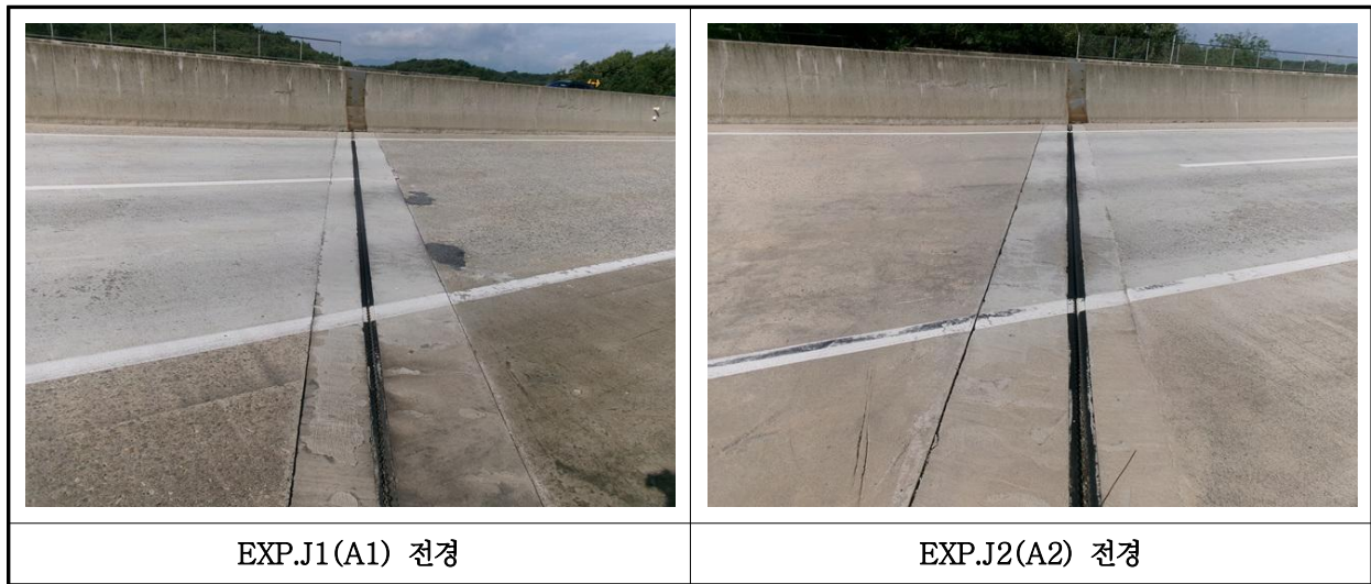
【사진 35.3.15】 신축이음장치 전경
