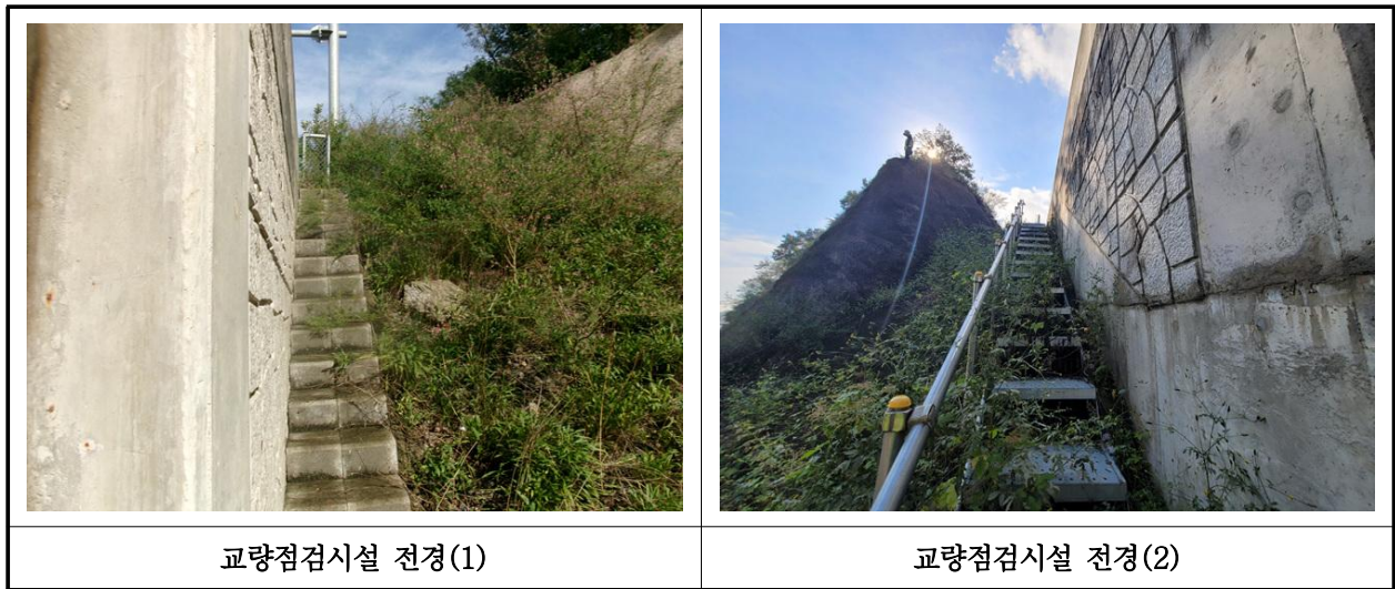
【사진 35.3.24】 교량 점검시설 전경
