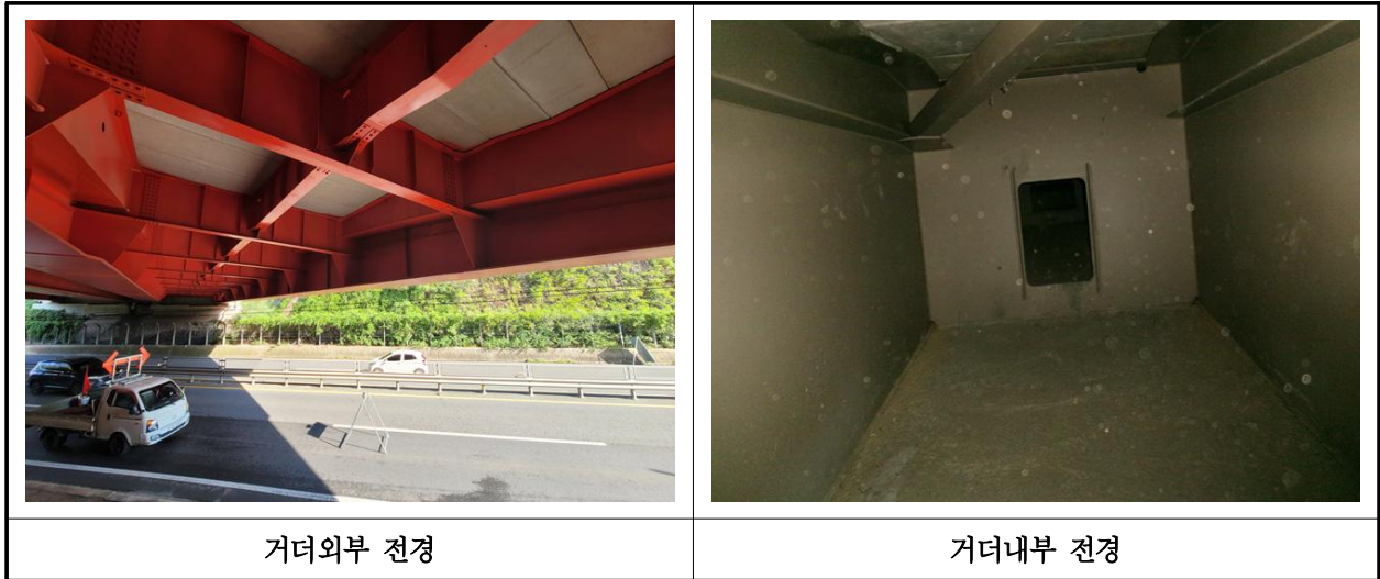
【사진 35.3.4】 거더 전경
