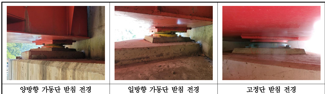
【사진 35.3.11】 교량받침 전경
