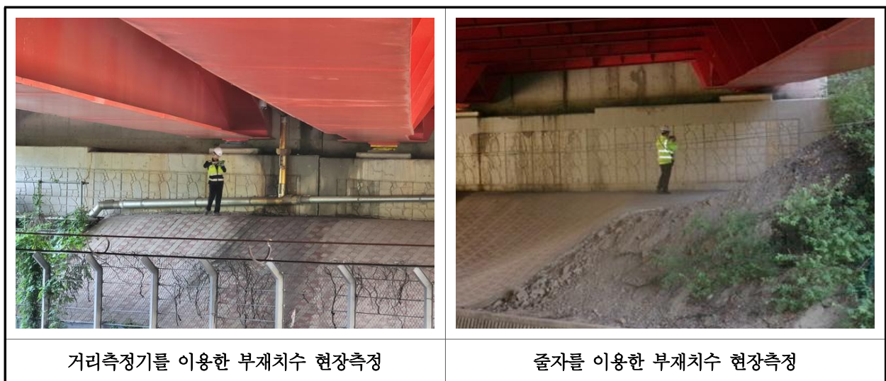
【사진 35.2.1】 부재 현장측정 전경
