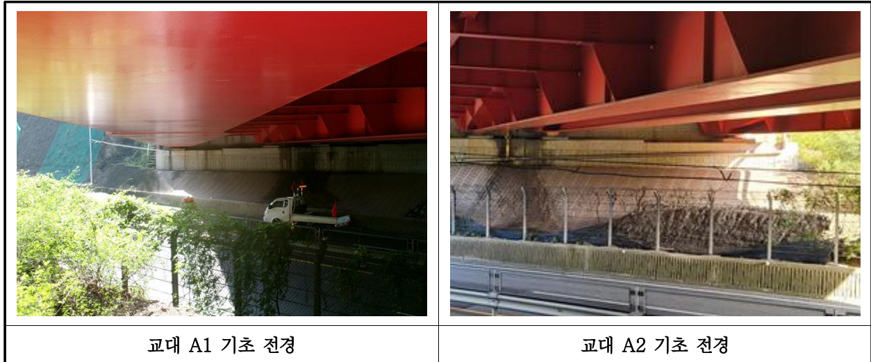
【사진 35.3.10】 기초 전경
