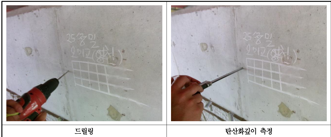
【사진 35.4.3】 탄산화 깊이 측정 현장사진
