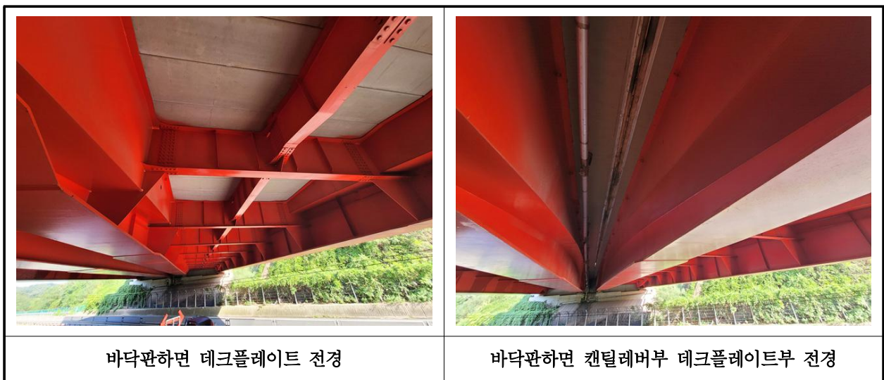
【사진 35.3.2】 바닥판하면 전경
