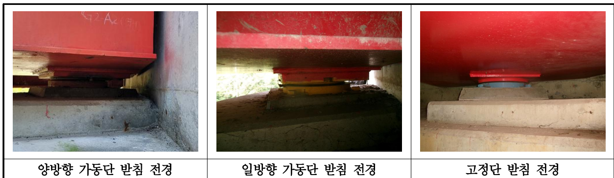
【사진 35.3.36】 교량받침 전경
