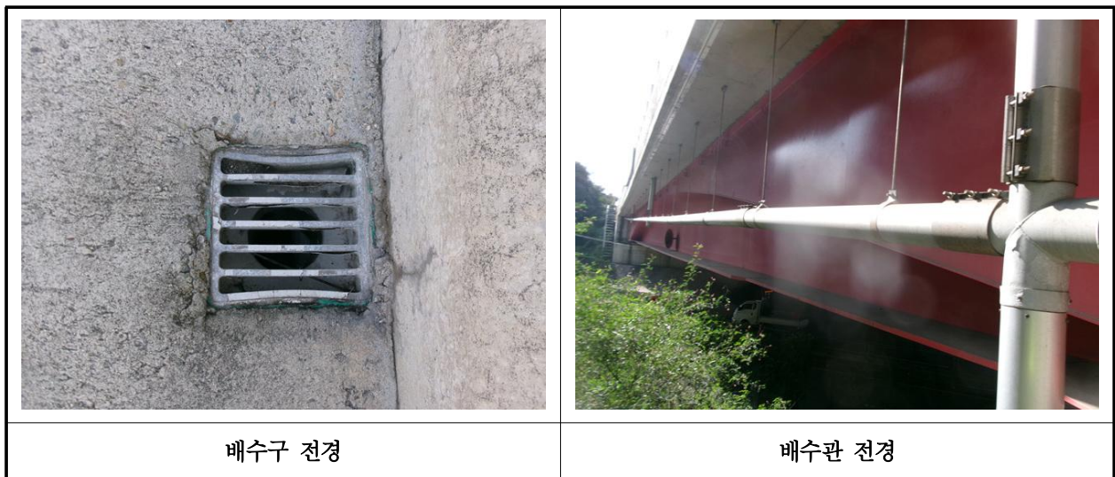
【사진 35.3.45】 배수시설 전경
