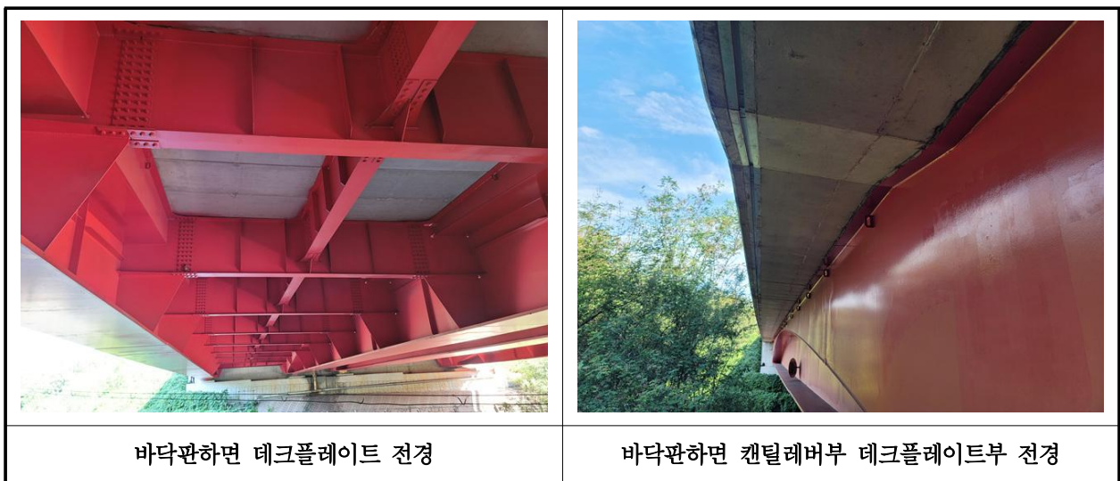
【사진 35.3.27】 바닥판하면 전경
