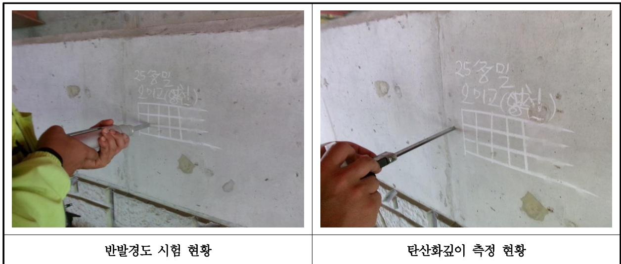
【사진 35.4.1】 콘크리트 내구성조사 현황
