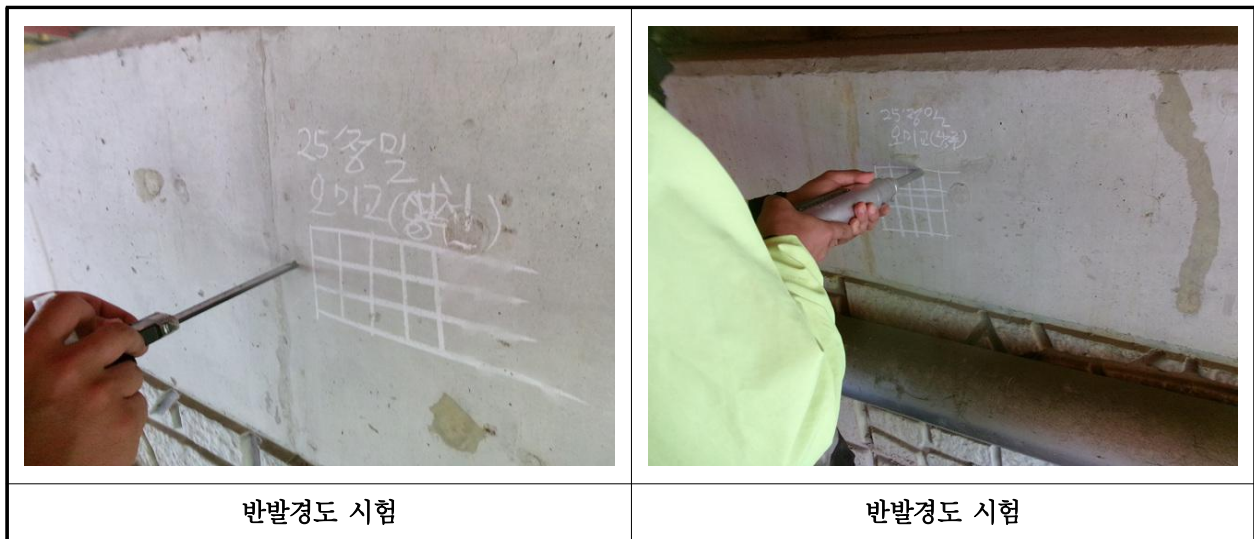
【사진 35.4.2】 반발경도시험 현장사진
