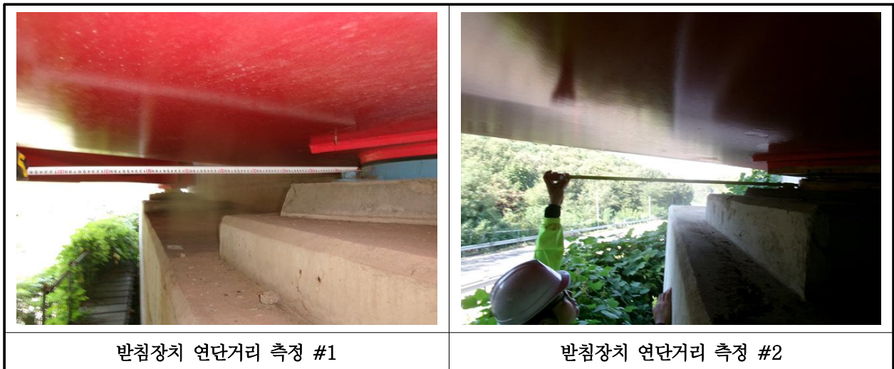
【사진 35.3.38】 교량받침장치 연단거리측정
