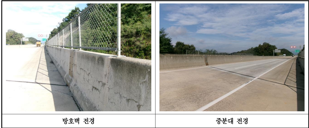
【사진 35.3.47】 방호벽 및 중분대 전경
