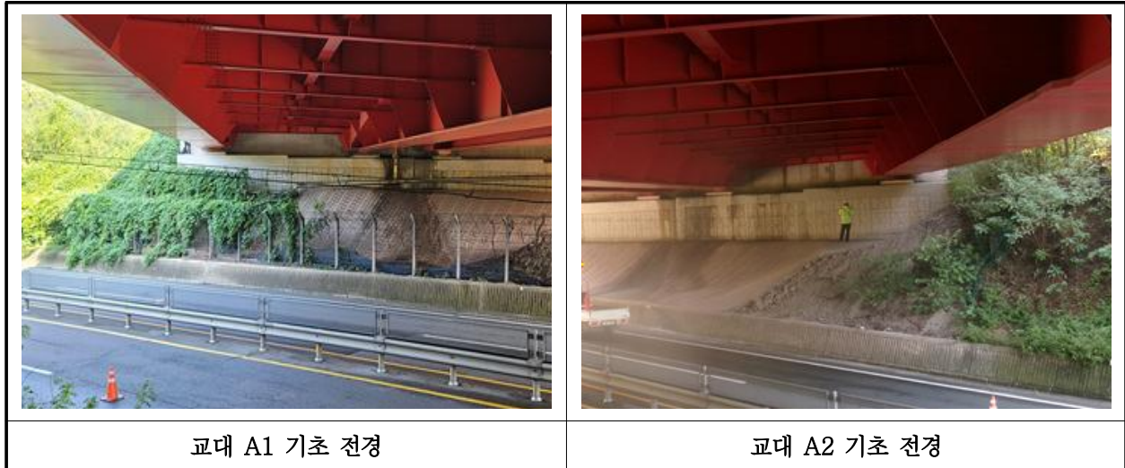
【사진 35.3.35】 기초 전경
