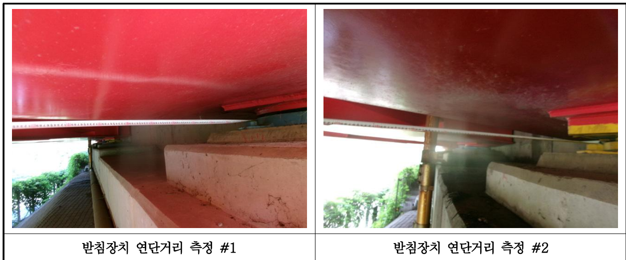
【사진 35.3.13】 교량받침장치 연단거리측정
