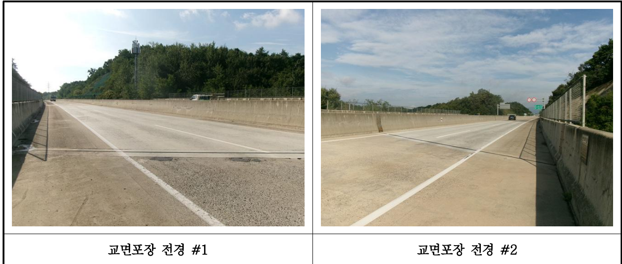
【사진 35.3.18】 교면포장 전경
