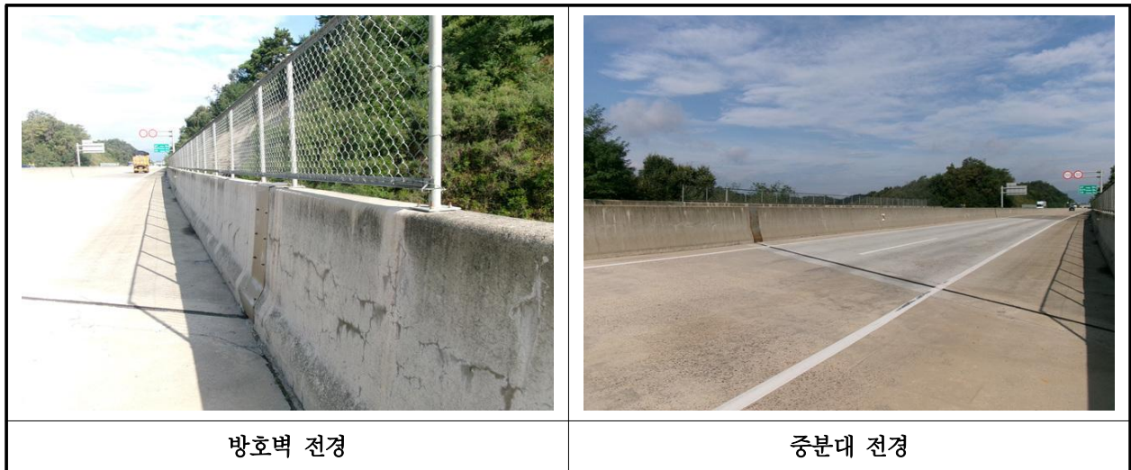
【사진 35.3.22】 방호벽 및 중분대 전경
